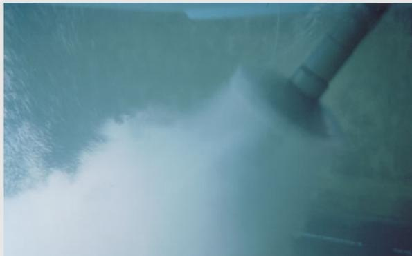
Tanque de aeração com 10un de ABM160 20CV
